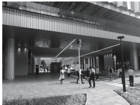
(写真5) 竣工後写真
