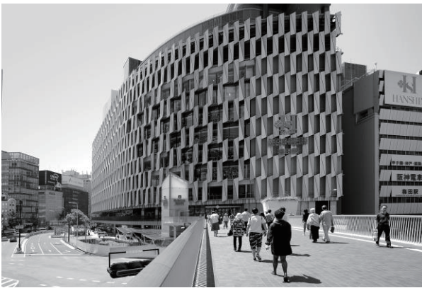
(写真3) I期竣工時
