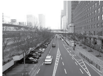
写真 4 現在の中之島通の車道の状況（渡辺橋駅付近）
