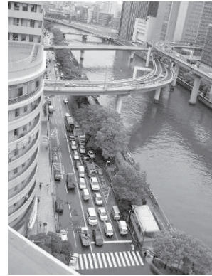
写真2 新線工事前の中之島通の状況 (渡辺橋駅付近)
