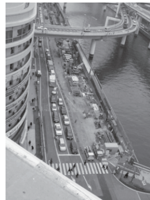
写真3 新線工事中の中之島通の状況 (渡辺橋駅付近)
