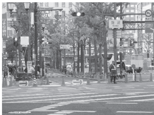
写真 - 2 側道閉鎖状況
