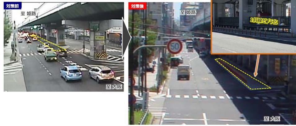
● 対策前後でビデオ撮影し、車線変更車両を計測した結果、カラー舗装化及び案内標識設置により、走行する車線が事前に把握しやすくなったことで、車線変更台数が削減、事故発生の危険性が低下。
