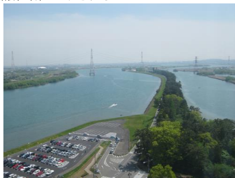
写真-1 左から長良川、油島締切堤、揖斐川、上流側（北）から下流側（南）を望む
